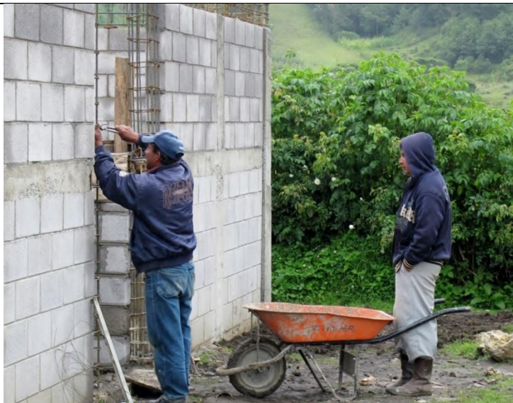
Figura 10. Ejemplo de proyecto comunitario: construcción de la Casa Materna en Pett, Santa Eulalia, con trabajo voluntario comunitario
